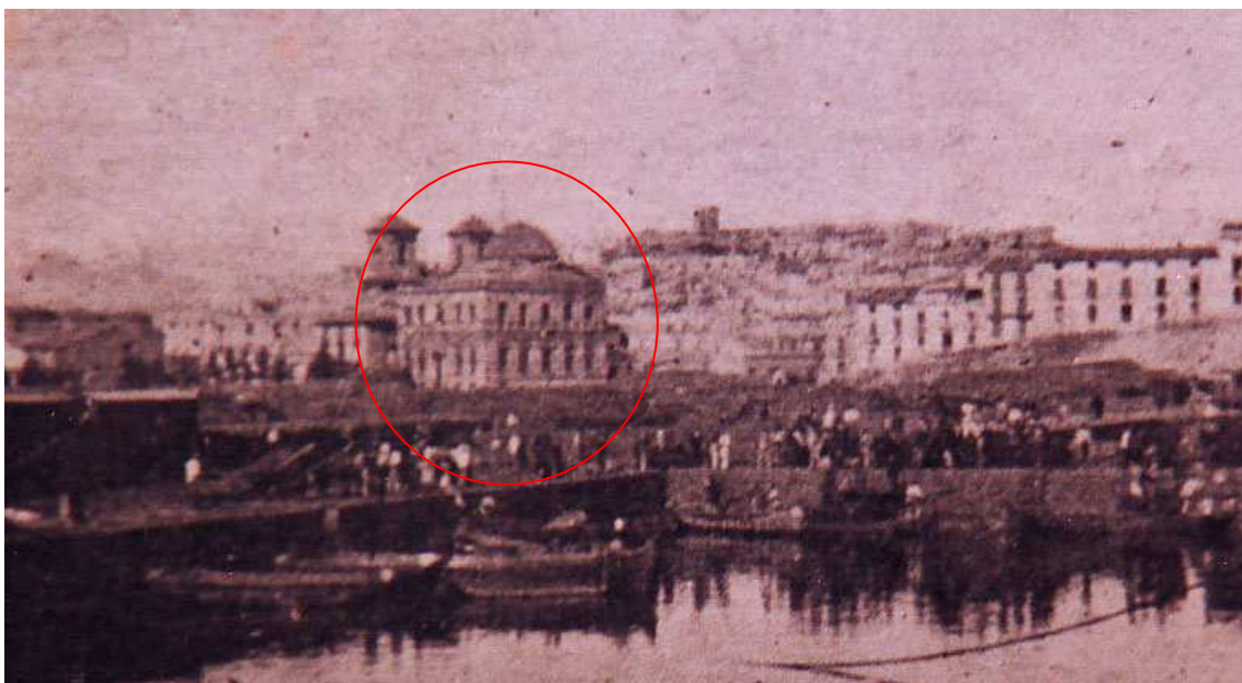
Imagen del edificio tomada desde un barco pesquero.
